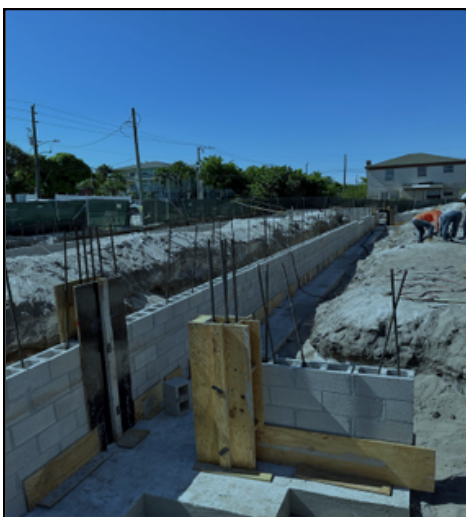
Poured Foundation & Stem Wall – Site D
